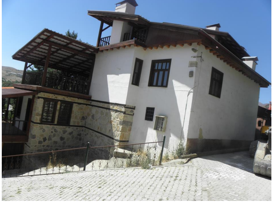
Görsel 1. Arapgir Seher Atmaca (Keşiş) Konağı ilk yapı'dan.
